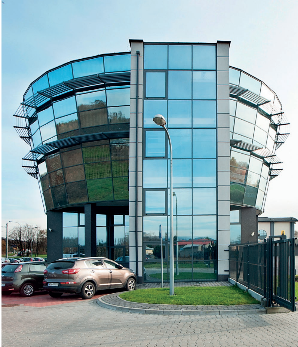
Stazione dei Vigili del Fuoco, Nowy Sącz
